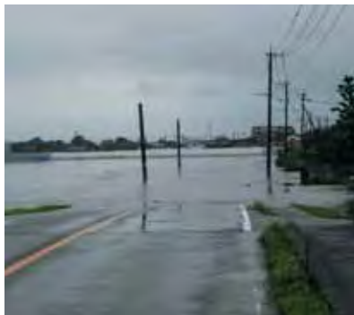
▲冠水した道路
