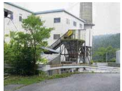
▲小郡市・筑前町衛生施設組合清掃センター(解体前)
