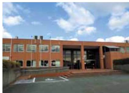
▲小郡市体育館
