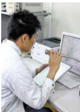
市役所の親局から市内60か所に設置した屋外スピーカーを通じて災害情報を一斉に伝達します。「全国瞬時警報システム」と連動しており、緊急地震速報を受信して瞬時に放送することができます（震度5弱以上）。
