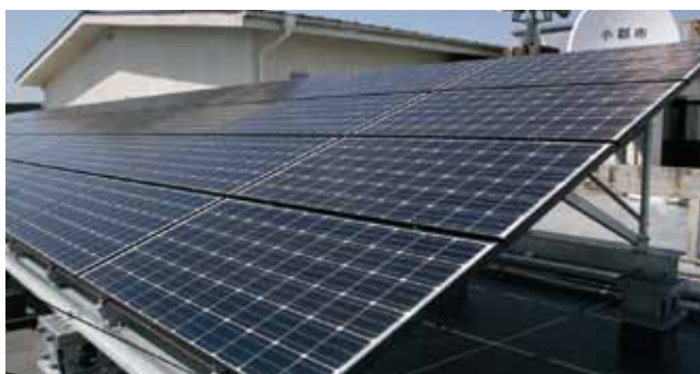
●太陽光発電システム設置事業
