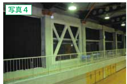
▲体育館耐震補強およびアスベスト除去事業
