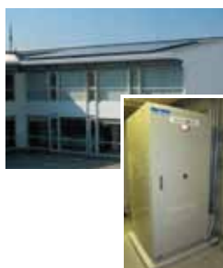
熊本県苓北町役場では、災害本部と避難所を兼ねた庁舎に設置。停電時には太陽光発電で蓄電池にためた電力を夜間の館内照明や通信機器などに使用。
