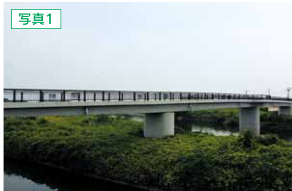
▲満天橋(全長119.5m 幅員4m)
