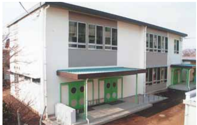
▲(写真 2) 三国小学校校舎増築
