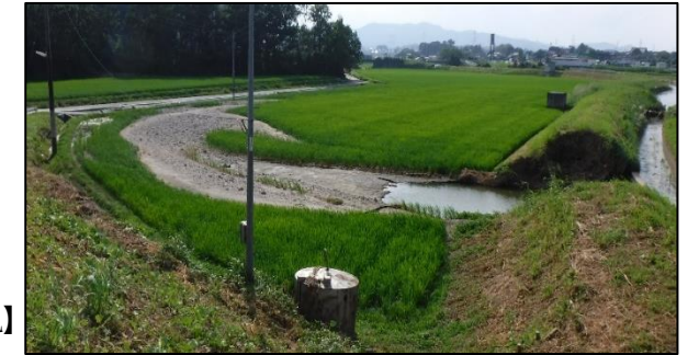
【令和元年7月豪雨：草場川破堤状況】
