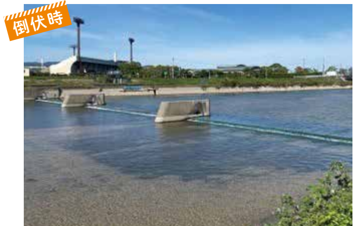
大板井堰の様子。上が通常(起立)時、下が倒伏時。
